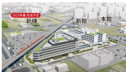
2023 年春より稼働の新棟
