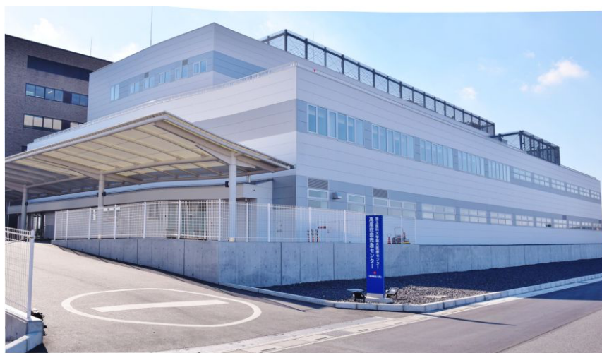
高度救命救急センター棟
