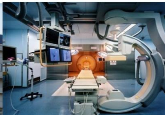
MRI 室と直結した血管造影室
